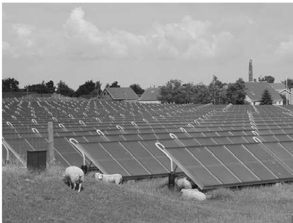
Рис. 4.26. ФЭП на кровле здания
