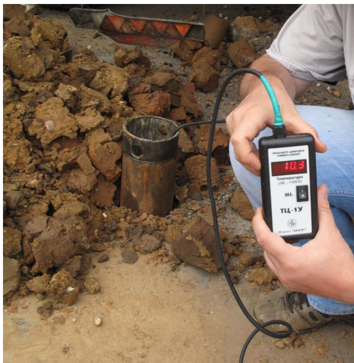
Измерение температуры в скважине
