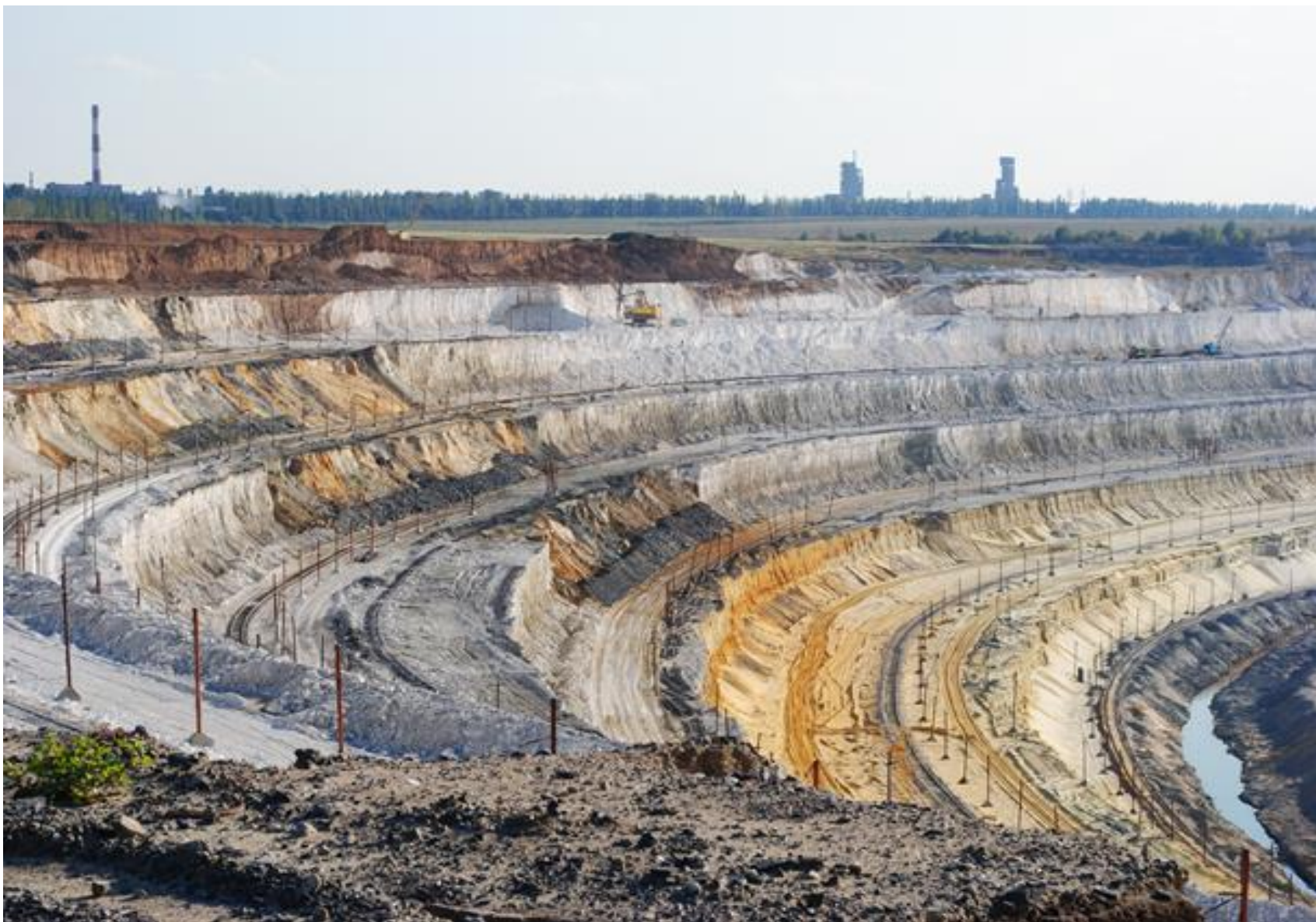
Противофильтрационные завесы на Лебединском ГОКе
