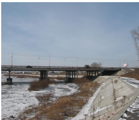
Рис.15. Укрепленные бетонными плитами берега р.Чита
