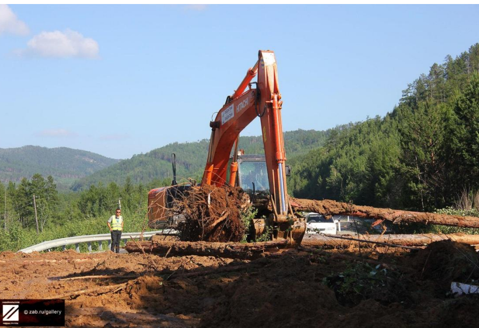
Расчистка 17 км федеральной трассы Амур после схода селя (июль 2018 г.)
