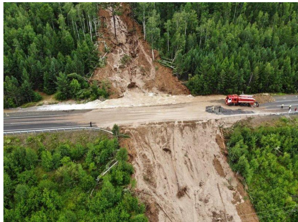
Тот же участок федеральной трассы Амур после расчистки селевых накоплений (июль 2018 г.)
