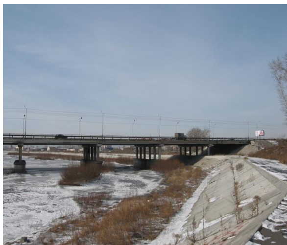
Рис.15. Укрепленные бетонными плитами берега р.Чита
