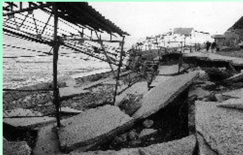
Рис. 6.2. Разрушение берегоукрепительных сооружений в северо-западной части Адлерского мыса (февраль 1964 г.)
