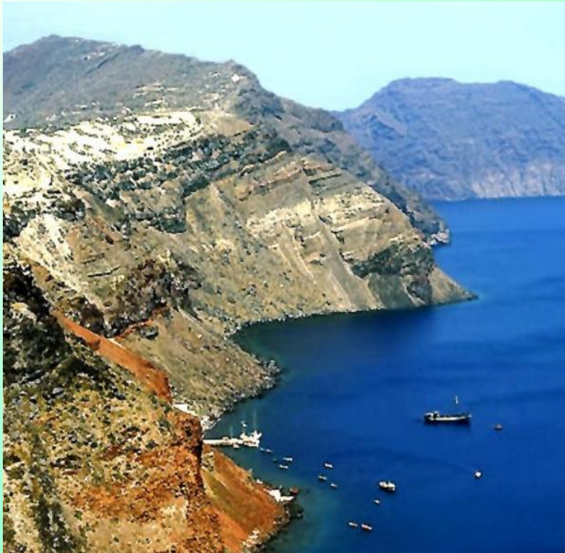
Разрушение морского берега
