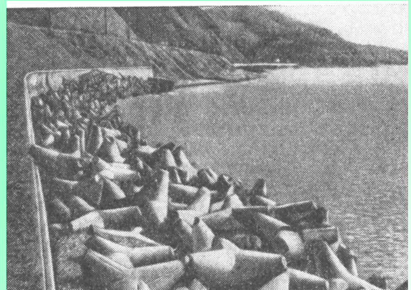
Наброска фигурных бетонных массивов
