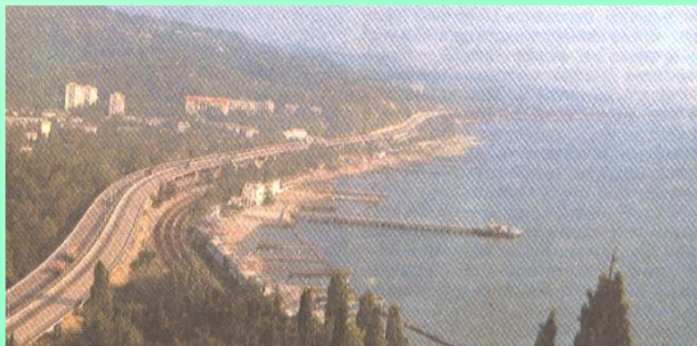
Берегоукрепительные сооружения в Хосте, Черноморское побережье Кавказа
