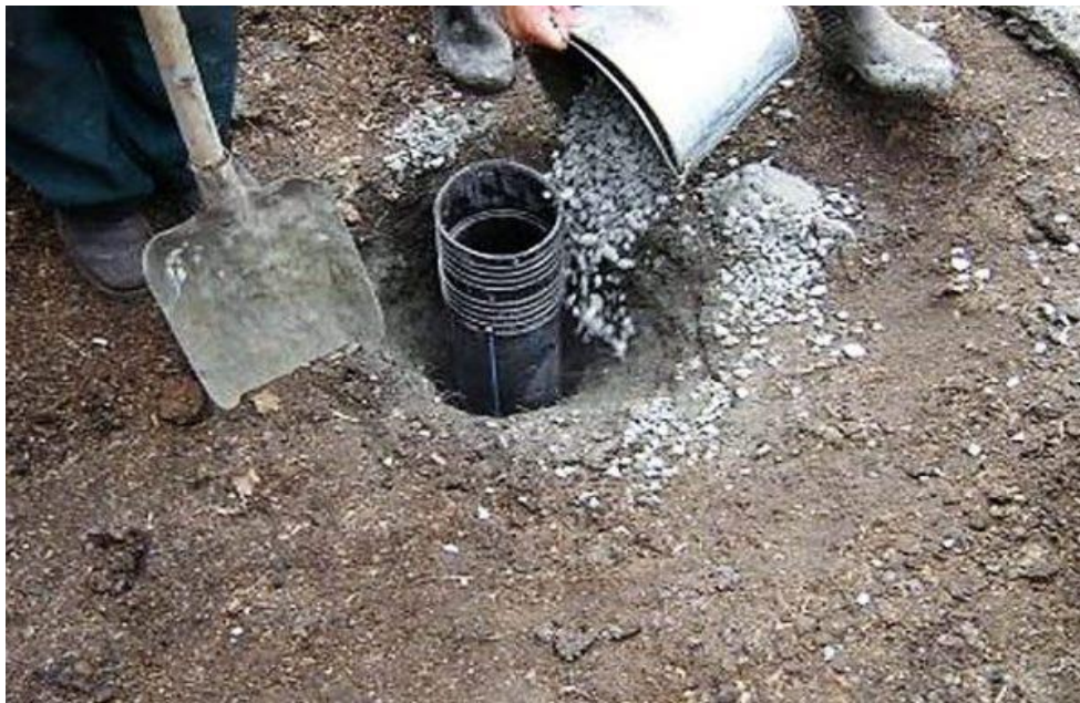
Тампонирувание скважины
