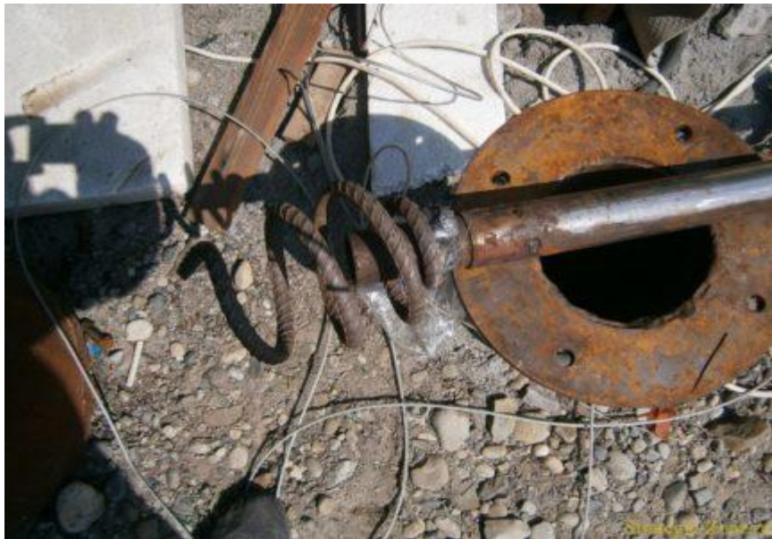
Приспособление для извлечения оборванного троса и насоса из скважины
