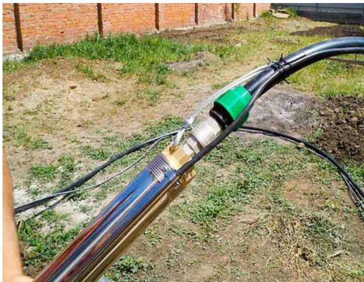
Крепление насоса на кабеле
