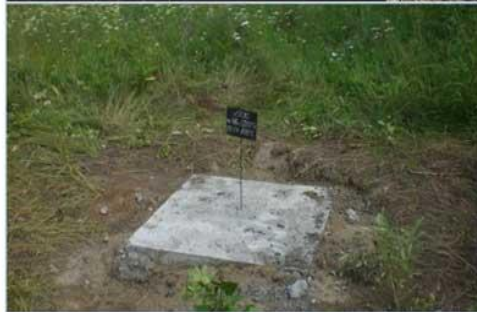
Бетонирование скважин
