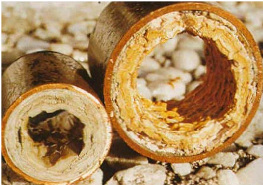
Известковый осадок на обсадных трубах
