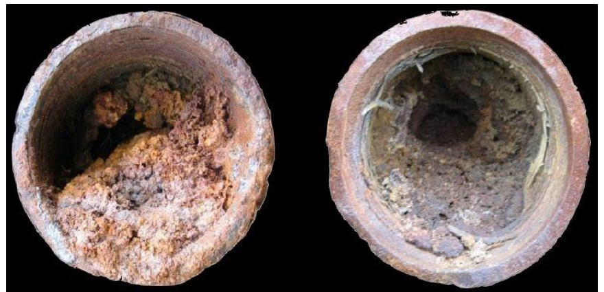
Заиливание обсадной трубы
