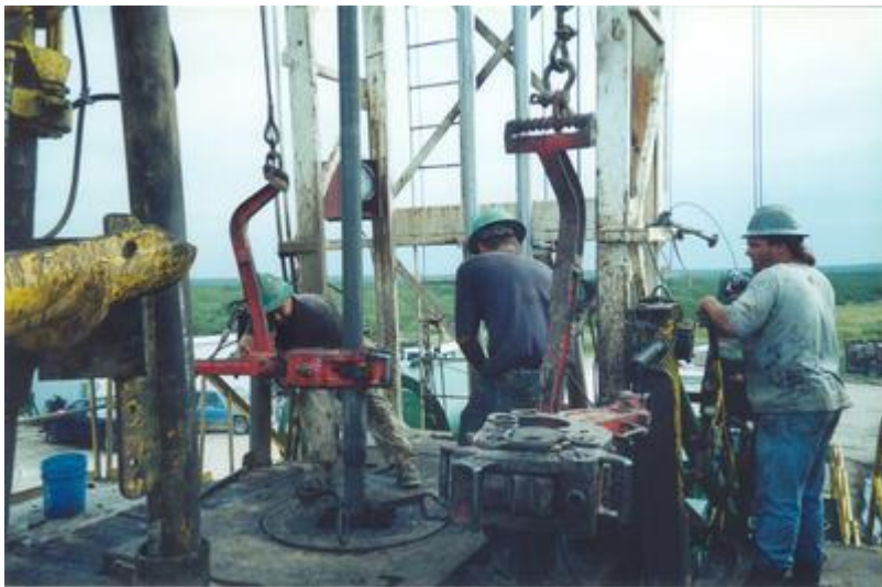
Капитальный ремонт скважин
