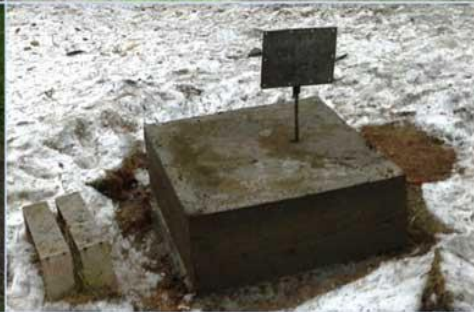
Бетонирование скважин
