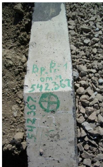
Рис. 7.24. Фото репера расположенного на шкафной стенке
