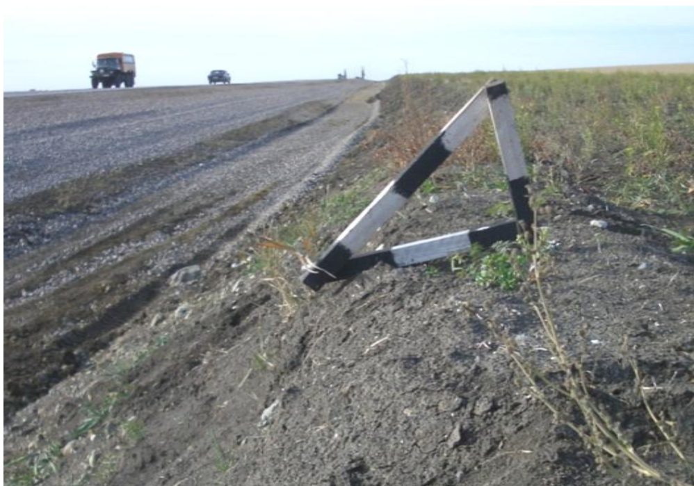
Рис. 7.32. Откосник, установленный по границе верхней бровки выемки
