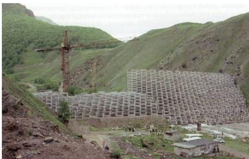
Рис. 18. Монтаж селеудерживающего сооружения
