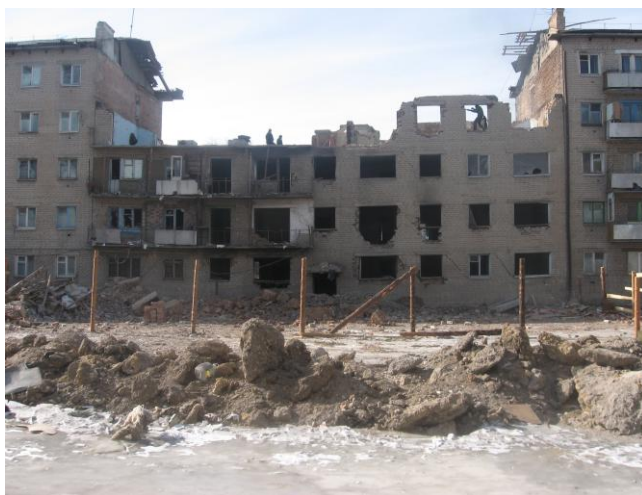
Рис. 55. Демонтаж деформированной центральной части жилого дома по ул. Ползунова, 26 в г. Чита, после оттаивания льдистых грунтов и осадки свайных фундаментов (март, 2011 г.)
