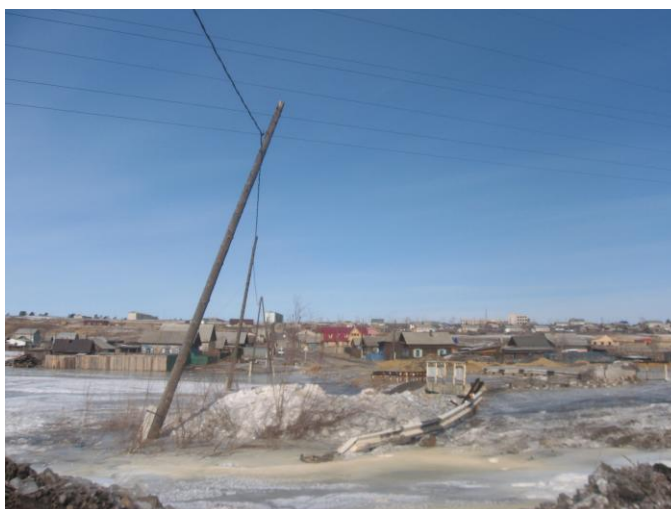
Рис. 57. Гетерогенная наледь на участке моста через руч. Смоленка в пригороде г. Чита (март 2011 г.)
