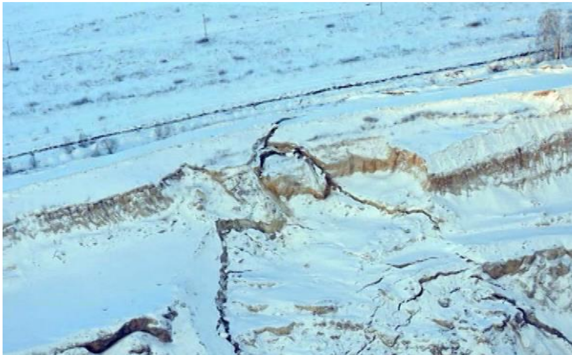
Рисунок 2- Оползень на борту карьера
