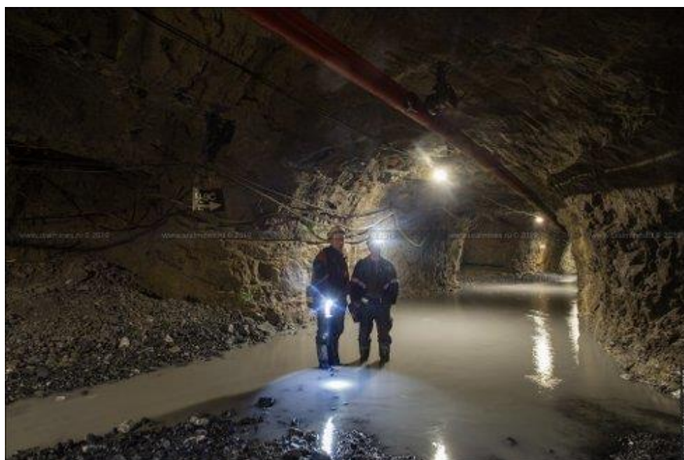
Рисунок 1- Обводненная подземная горная выработка
