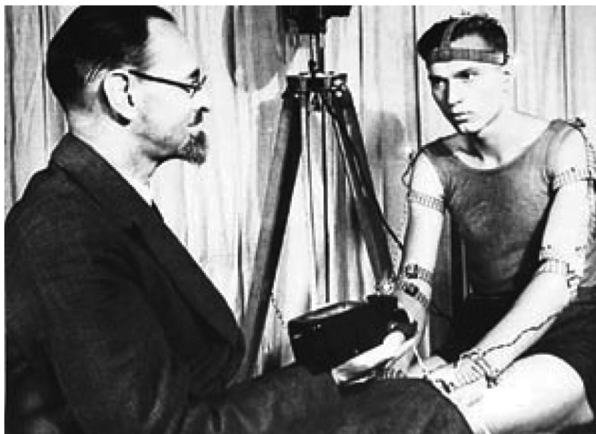
Рис. 22. Н.А. Бернштейн готовит испытуемого к записи циклограммы — графика зависимости прикладываемых мышечных усилий от времени
